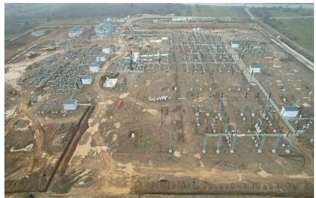
Слика бр.2- Изградба на 400/110 kV ТС Охрид
