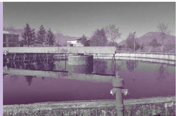
ПРЕЧИСТИТЕЛНА СТАНИЦА ВРАНИШТА
