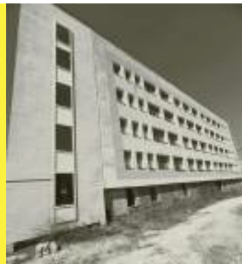
Надворешна состојба на неизграден објект на ЈЗУ Општа болница Кичево
