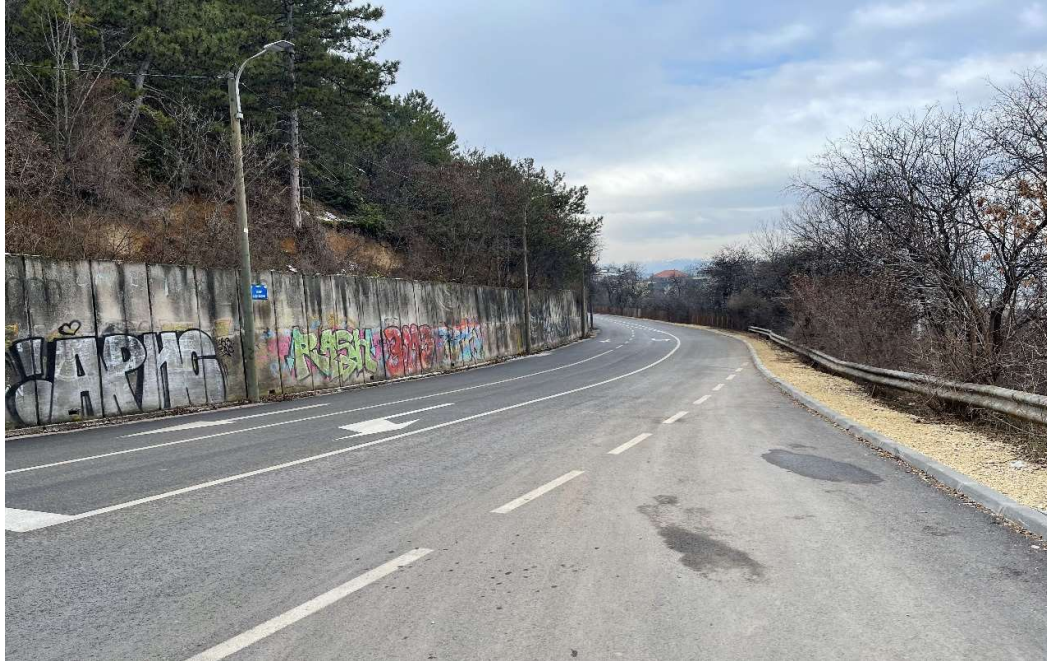
Реконструкција на улица „Тодор Александров“
