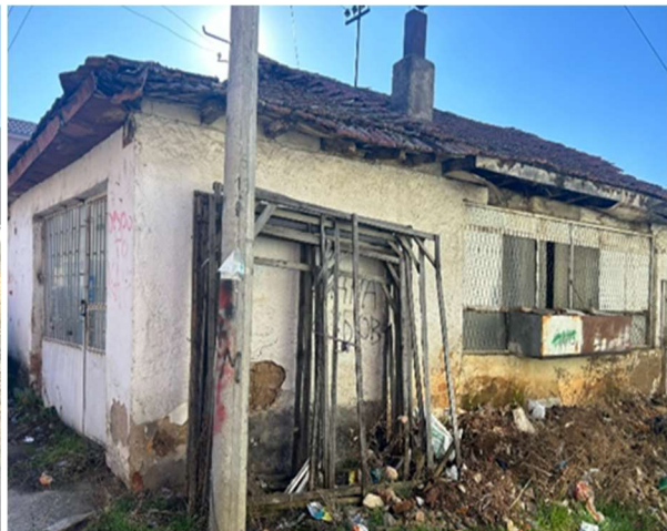
АДИССПДП –Објект во Прилеп
