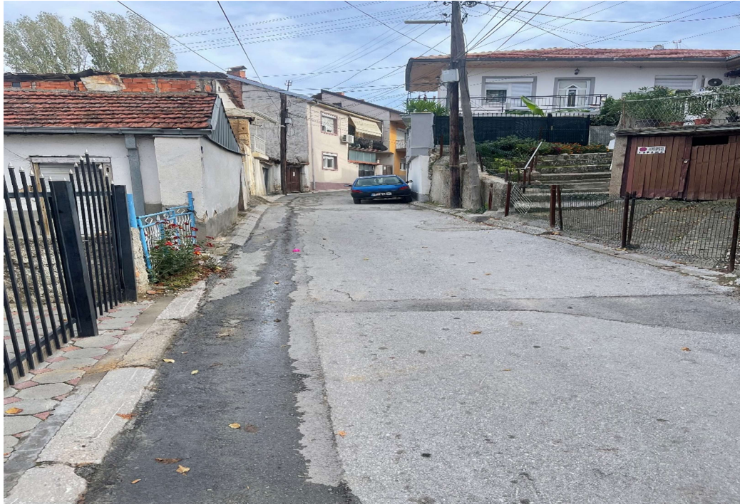
Реконструкција на водоводна мрежа на улица „Илија Игески“
